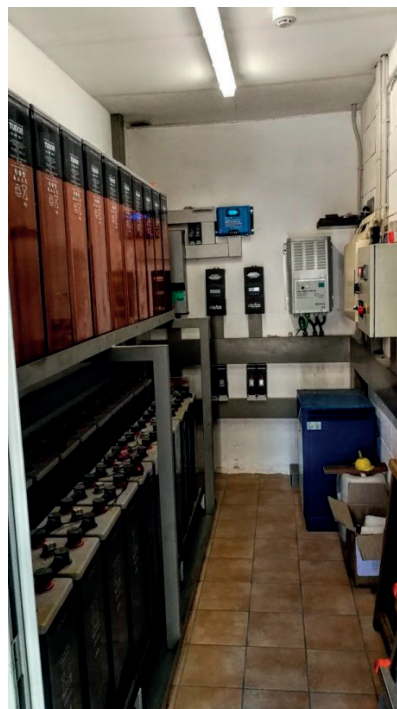
FIGURA 22. Sala de bateries. (Fotografia de Jaume Ramon Solé.)
