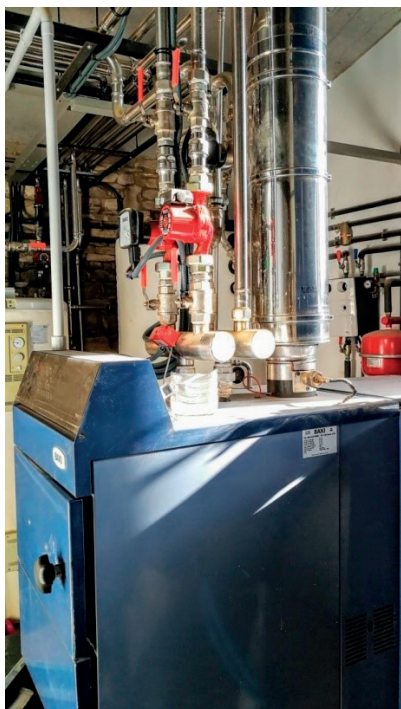
FIGURA 21. Sala de calderes. (Fotografia de Jaume Ramon Solé.)
