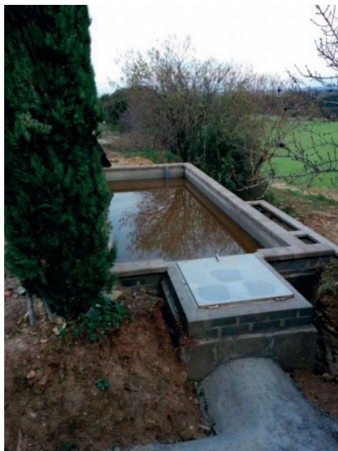
FIGURA 17. Depuradora d'aigües residuals. (Fotografia de Jaume Ramon Solé.)
